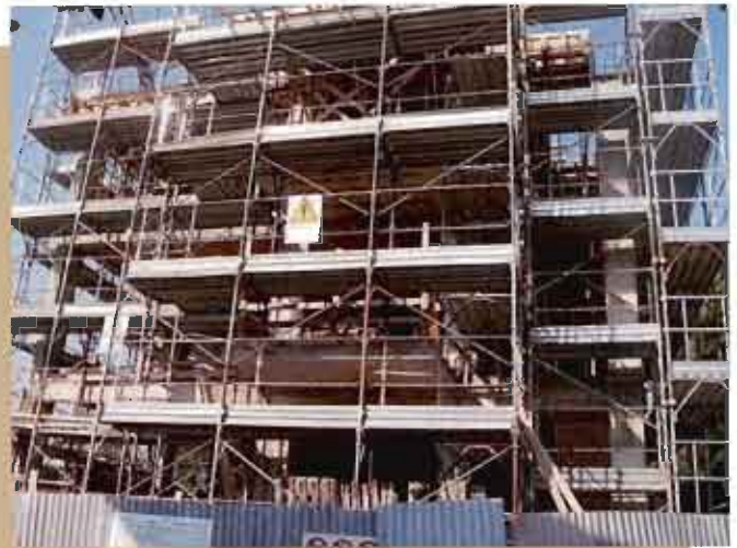
CANTIERE IN VIA TREVÌ - TERNI
