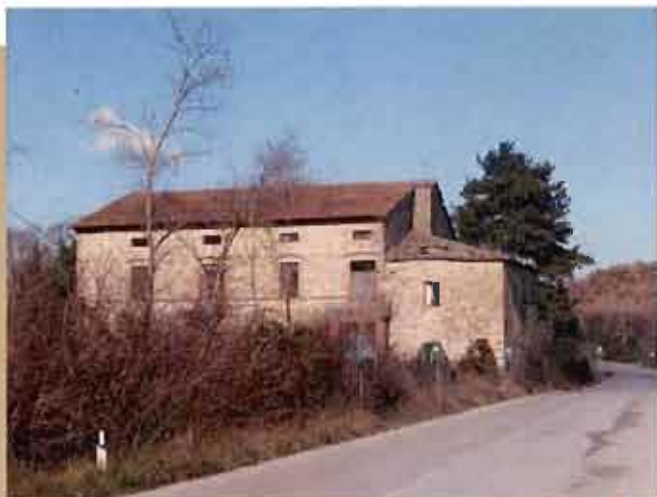
MESSA IN SICUREZZA DELLA "FATTORIA DI PANTALLA" SITO IN TODI (PG), FRAZIONE PANTALLA
