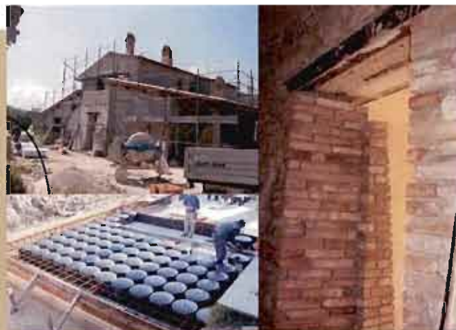
CANTIERE IN STRADA DI CASTELLUCCIO - NARNI
