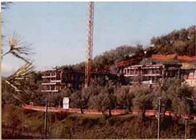
CANTIERE IN LOCALITA' MONTEFRANCO - TERNI
