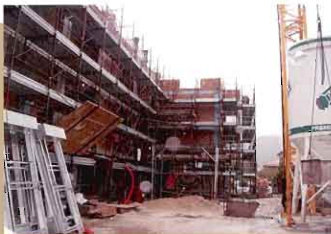
CANTIERE IN VIA MINERVA - NARNI
