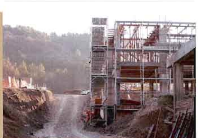
CANTIERE IN LOCALITA' POLENACO GIUNCANO - TERNI
