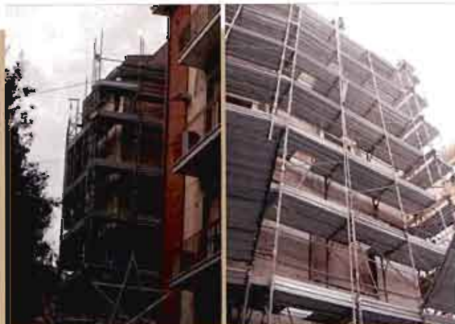
CANTIERE IN VIA NOBILI - TERNI
