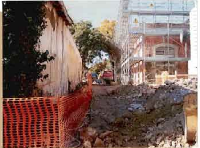
CANTIERE A COLLE DELL'ORO - TERNI
