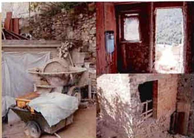
CANTIERE IN LOCALITA' CASTELDILAGO - TERNI
