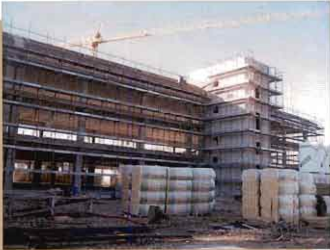
CANTIERE IN VIA BRAMANTE - TERNI
