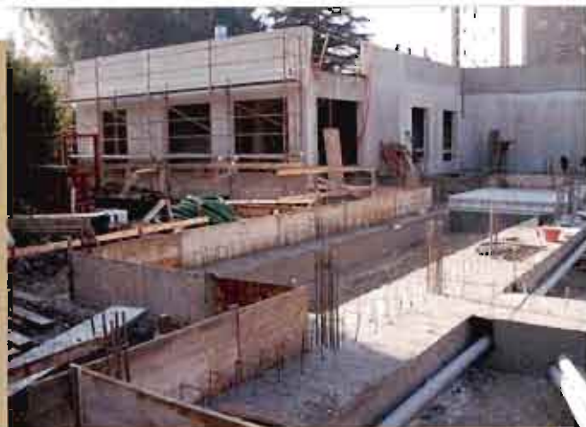
CANTIERE IN LOCALITA' COSPEA - TERNI
