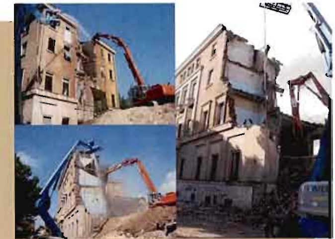
CANTIERE IN VIA SAURO - TERNI
