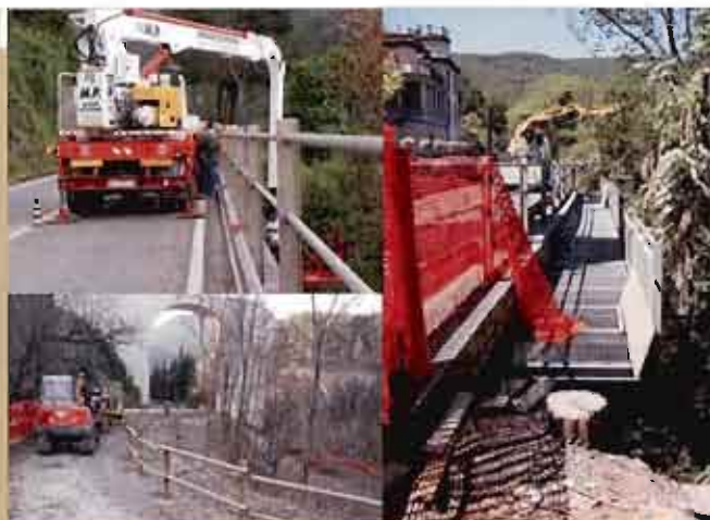
CANTIERE IN LOCALITA' GOLE DEL FIUME NERA - NARNI
