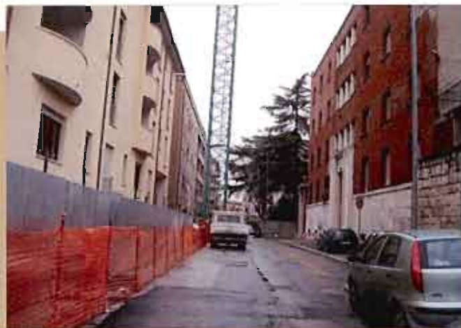
CANTIERE IN VIA ROMAGNOSI - TERNI
