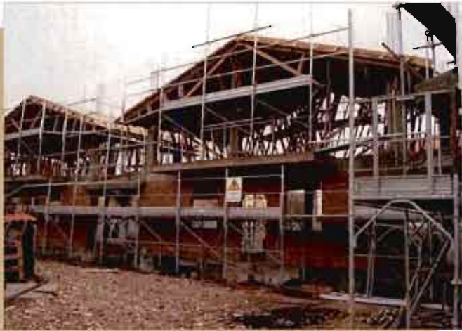
CANTIERE IN LOCALITA' CASTELLINA - TERNI
