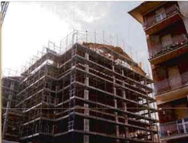
CANTIERE IN VIA VERRI - TERNI
